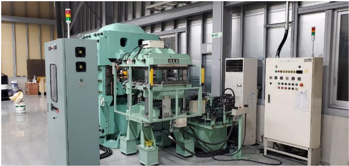
写真-5 1000TON プレス外観
